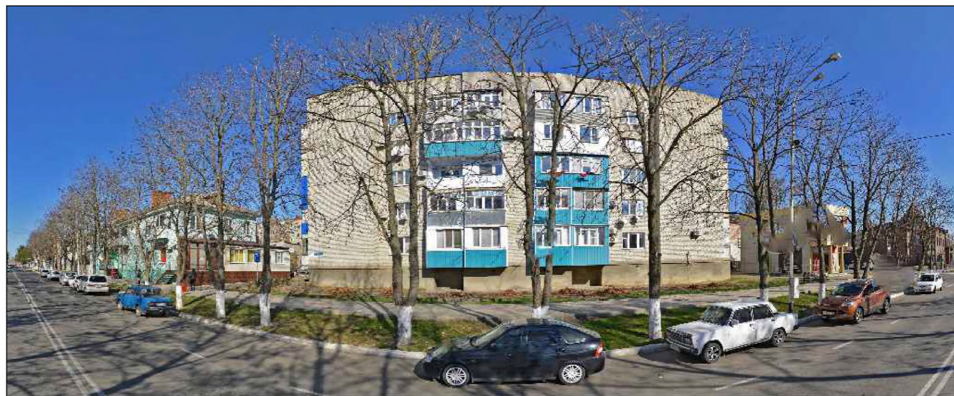
30-ти квартирный жилой дом в г. Темрюк
