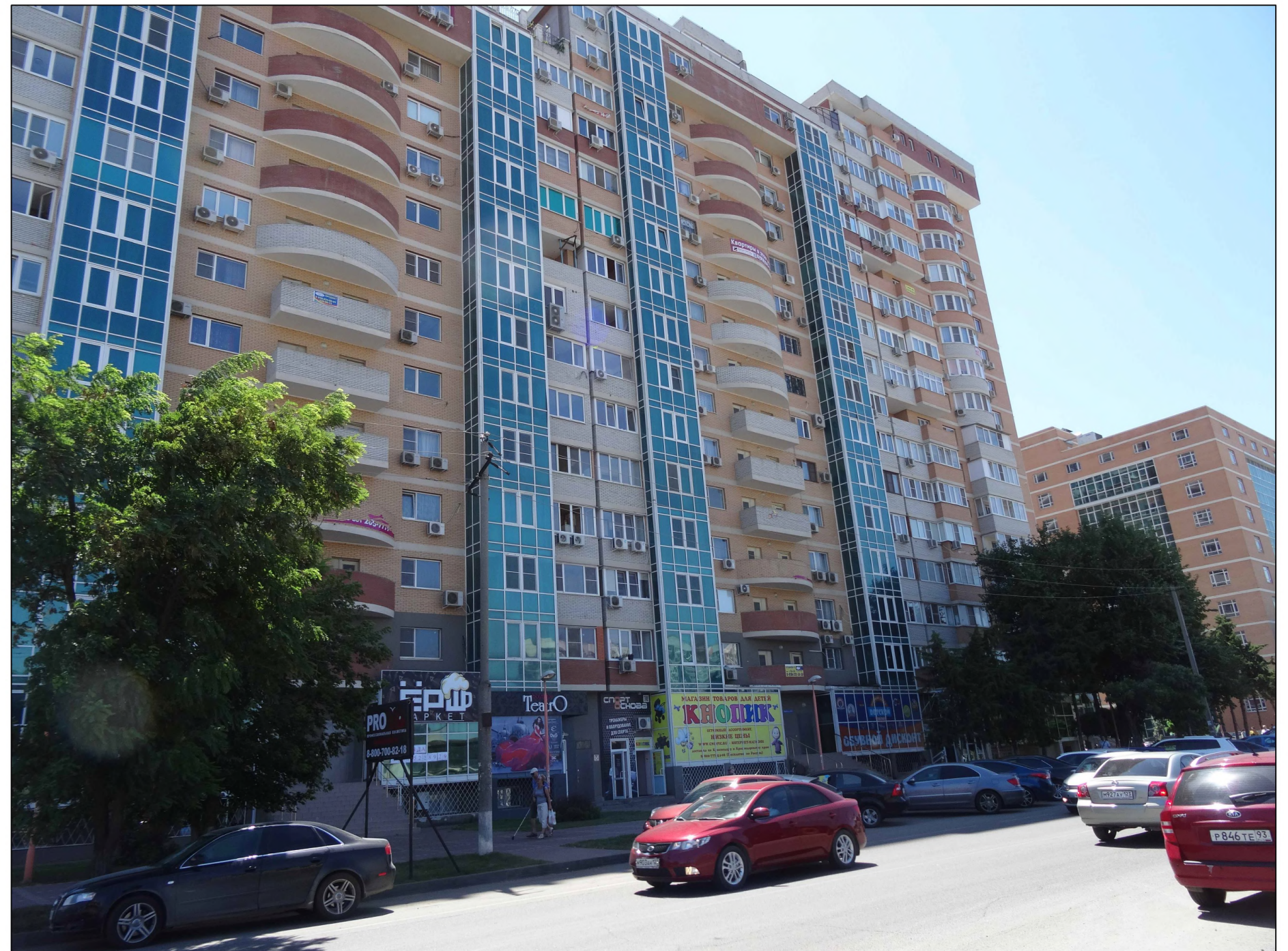
Застройка квартала по ул. Длинная в г. Краснодаре
