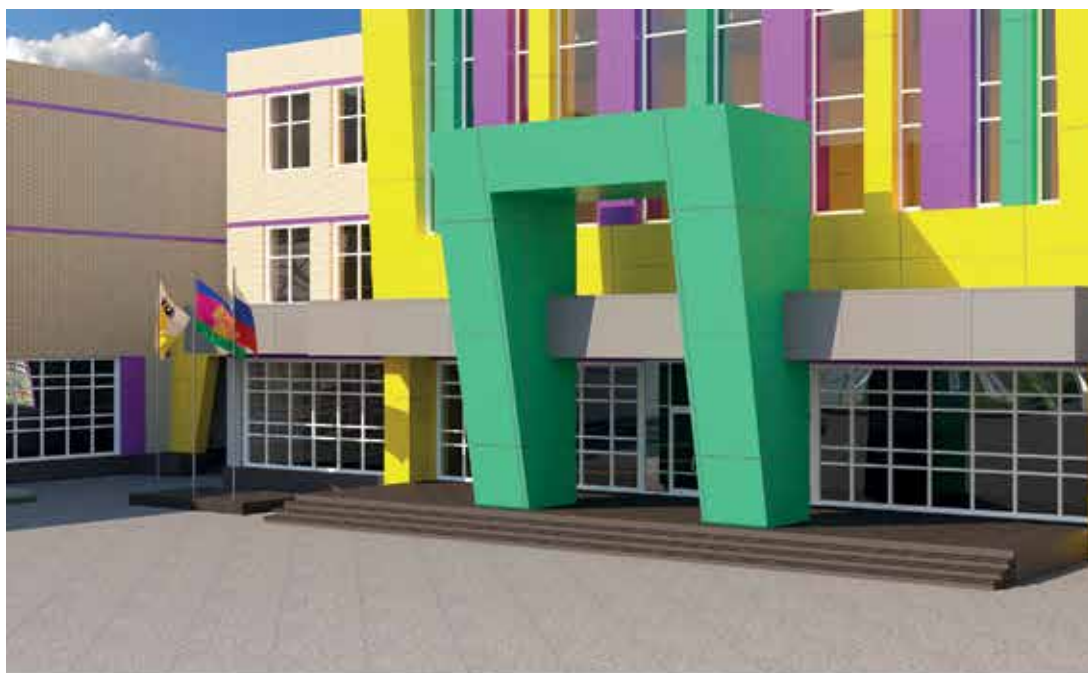
Общеобразовательная школа на 1550 мест по ул. Восточно-Кругликовская в г. Краснодаре
