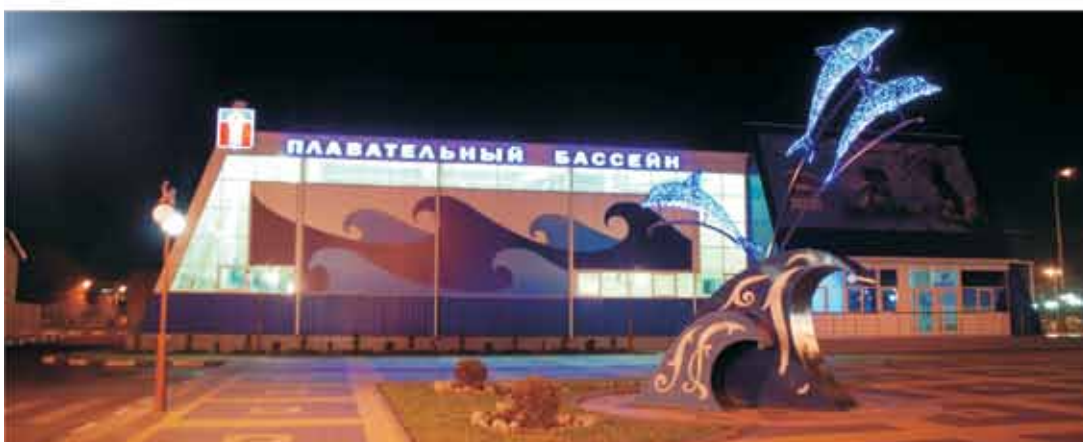
Комплексная реконструкция стадиона «Юность». Благоустройство территории прилегающей к спортивному комплексу с плавательным бассейном. Краснодарский край город Армавир
